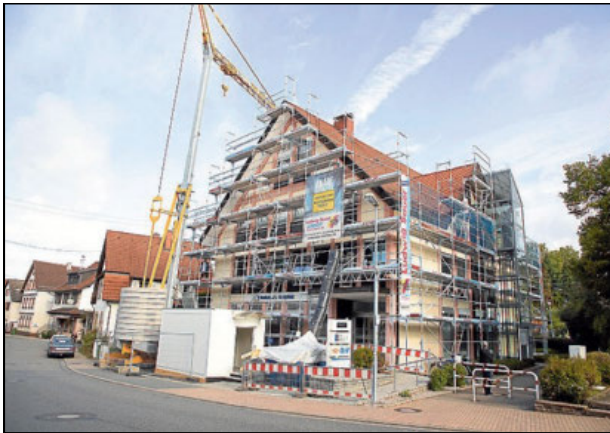
Aus der Volksbank-Filiale in Großsachsen wird ein Beratungszentrum für die nördliche Bergstraße. Foto: Kreuzer
